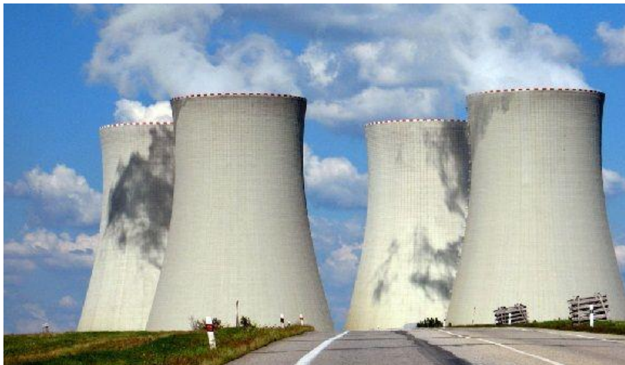
Figura 3 – Torres de arrefecimento com circulação natural do ar.
