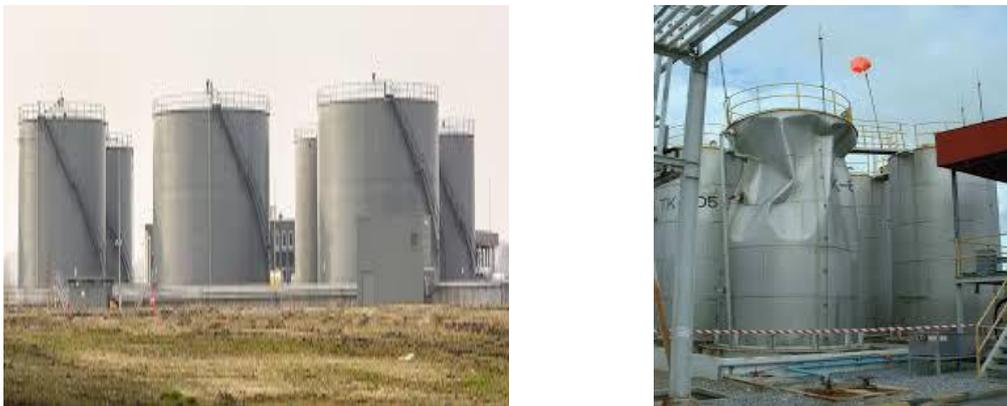
Figura 4 – Tanques industriais cilíndricos e tanque colapsado [1], [2]
